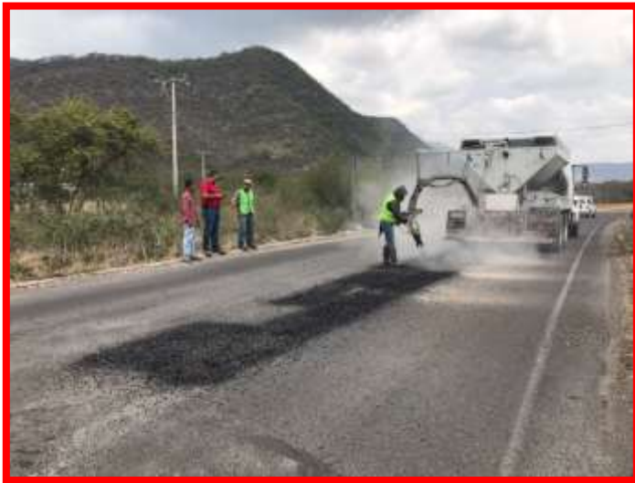
(Trabajos de bacheo carretera tramo Pinihuan-Lagunillas)
